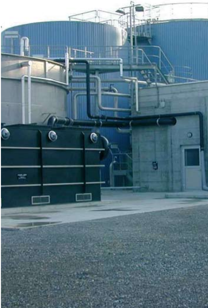
Biomar® mehrstufige biologische Abwasserbehandlungsanlage in der Milchverarbeitung
