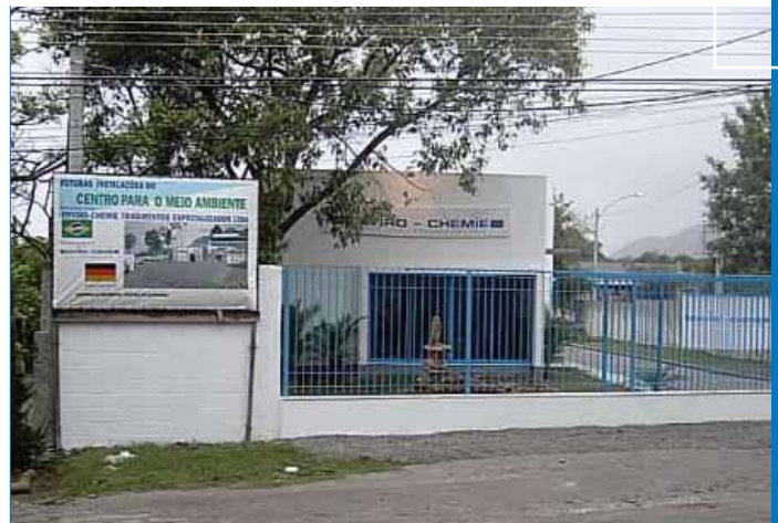
Abwasser-Reinigungszentrum in Rio de Janeiro Waste water treatment center in Rio de Janeiro
