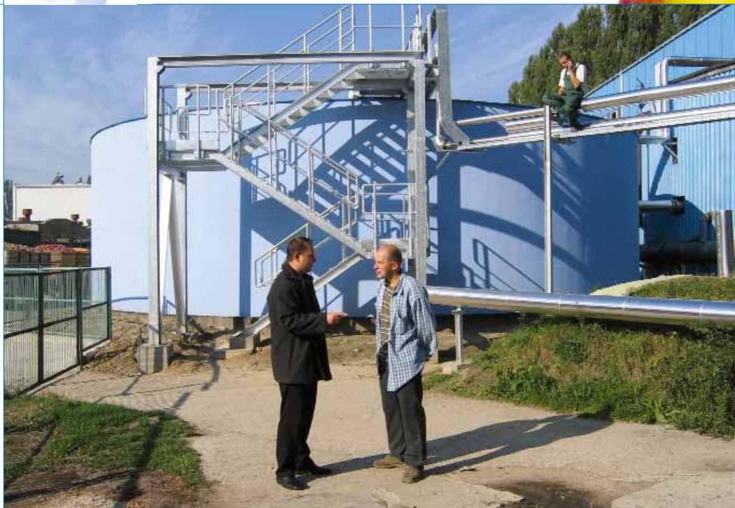
aerobe biologische Abwasserbehandlung BIOMAR® für einen Apfelsaftkonzentrathersteller aerobic biological waste water treatment BIOMAR® for a producer of apple juice concentrate
