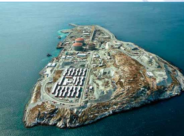
Hammerfest, Verflüssigungsanlage für Erdgas Hammerfest, LNG plant
